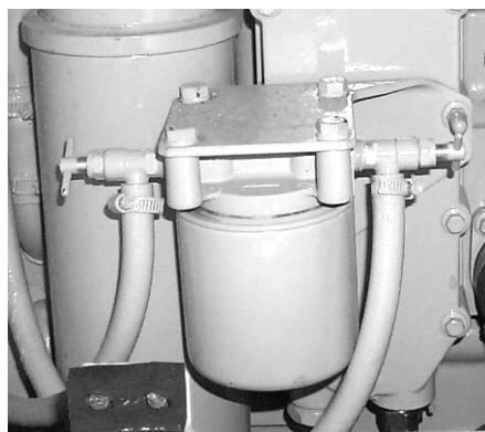
Рис. 5.29. Фильтр системы охлаждения (охлаждающей жидкости)
